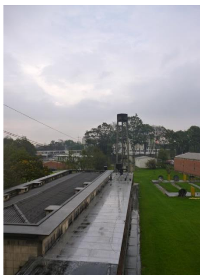
Imagen 3. Tanque alto desde el 3er. Piso del Edificio Químico
