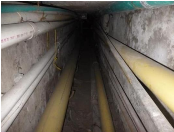
Imagen 15. Redes de aguas residuales en buen estado por cárcamo.
