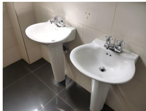
Imagen 14. Lavamanos en buen estado.
