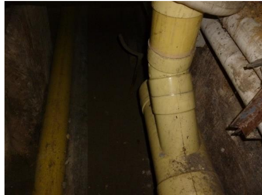
Imagen 25. Adaptador de inspección y limpieza en conducciones de aguas lluvias.
