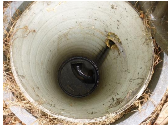
Imagen 33. Pozo de inspección en excelente estado.
