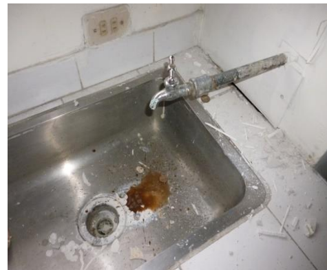
Imagen 8. Llave de poceta acoplada a red de hierro galvanizado
