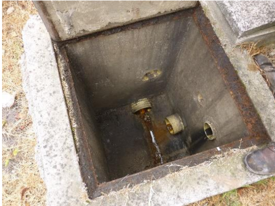
Imagen 32. Caja de inspección exterior en buen estado.
