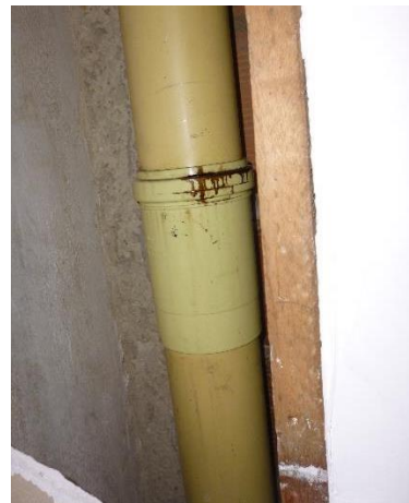
Imagen 27. Tubería de aguas lluvias por ducto, en buen estado.
