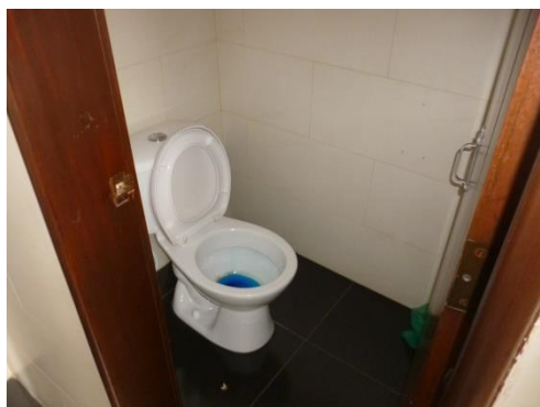
Imagen 13. Sanitario en buen estado.
