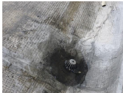
Imagen 30. Tragante de desagüe en cubierta.
