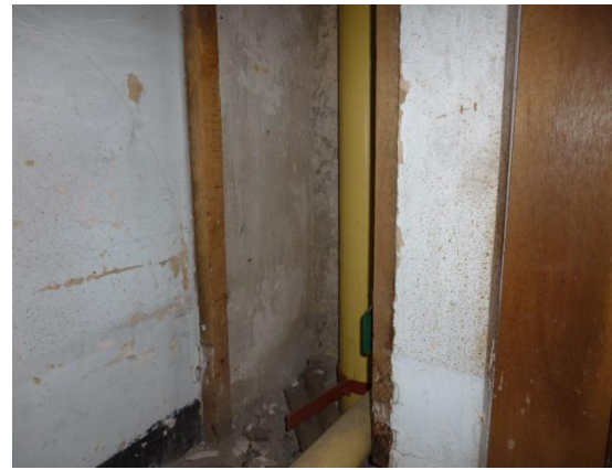
Imagen 16. Redes de aguas residuales en buen estado instaladas por ductos verticales.
