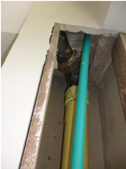
Imagen 28. Unión entre tuberías PVC y HF.
