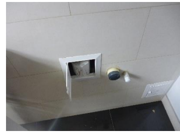
Imagen 23. Válvula mini-vent en ramales horizontales.
