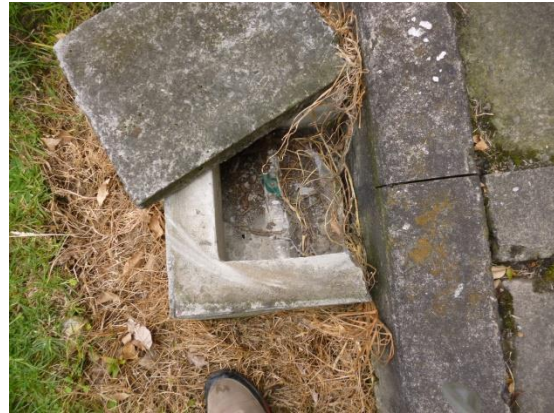
Imagen 6. Válvula de sectorización tipo paso directo de la red en PVC presión
